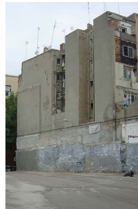
5. ENTRE CARRER ARC DEL TEATRE I CARRER DEL CID
