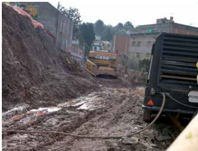
El carrer Portell durant les obres.
