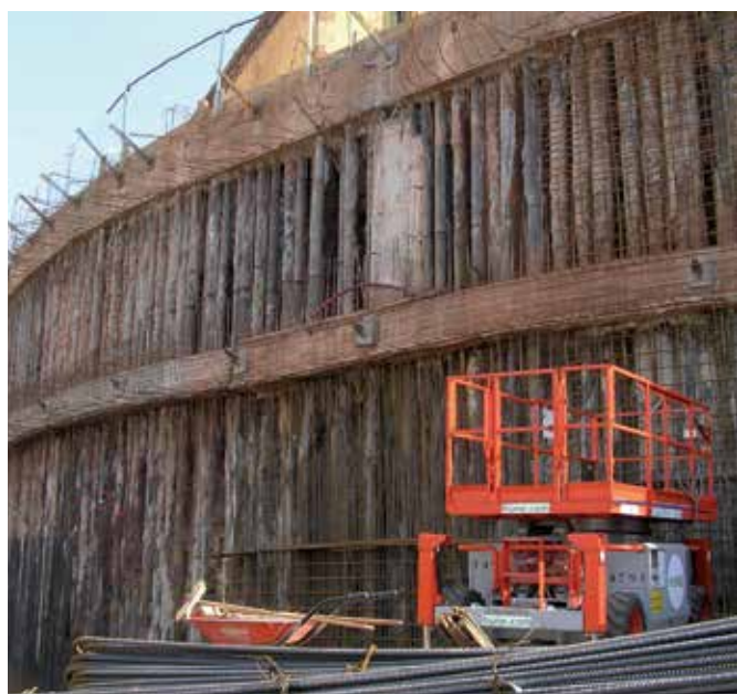
El carrer Portell durant les obres.
