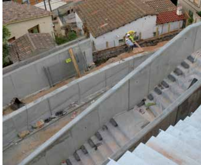
El carrer Portell durant les obres.
