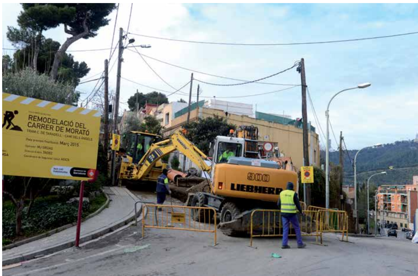
Remodelació del C. Morató.
