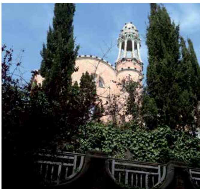
Torre Sant Jordi.
